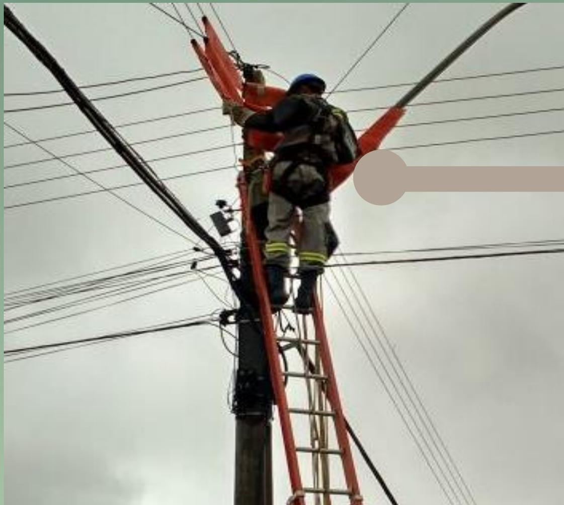
As luvas e mangas isolantes protegem as mãos, braços e antebraços do electricista contra o risco de contato acidental com a rede energizada evitando o choque elétrico.
