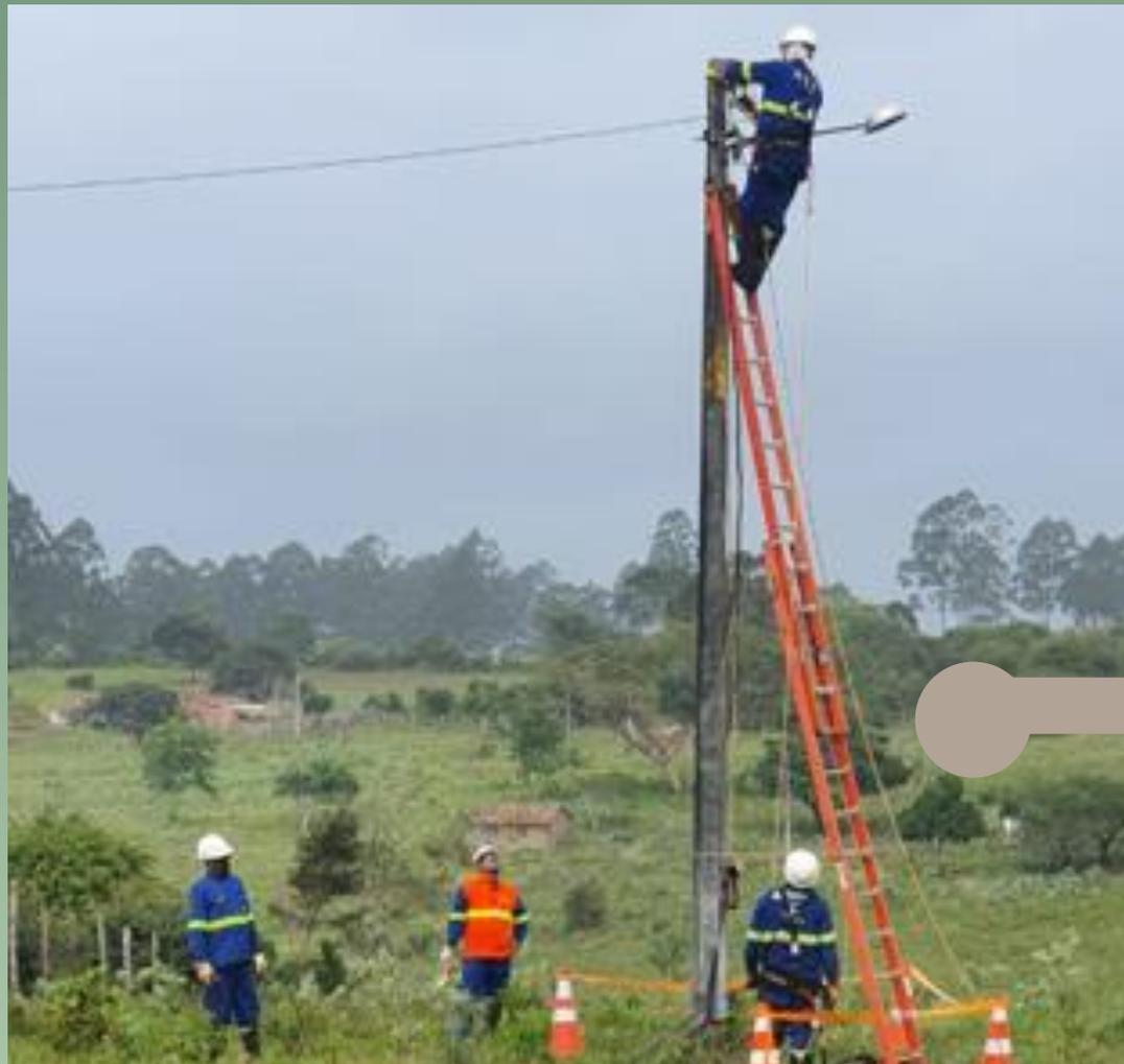
O equipamento de escala segura é primordial para realizarmos escaladas, pois protege o electricista contra queda de altura das estruturas.
